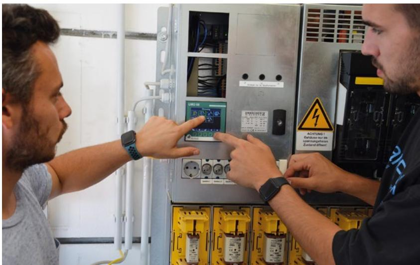
Bild 1. Mitarbeiter der e-netz Südhessen beim Einbau von Multimesgeräten im Rahmen des Pilotprojektes
